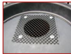
大孔的网罩和有孔顶盖无法阻挡蚊子出入
